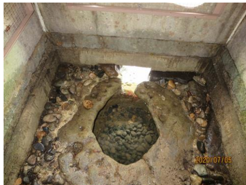
井戸枠の内側。馬蹄形に加工された金屋石が湧水口を覆うように置かれている。
